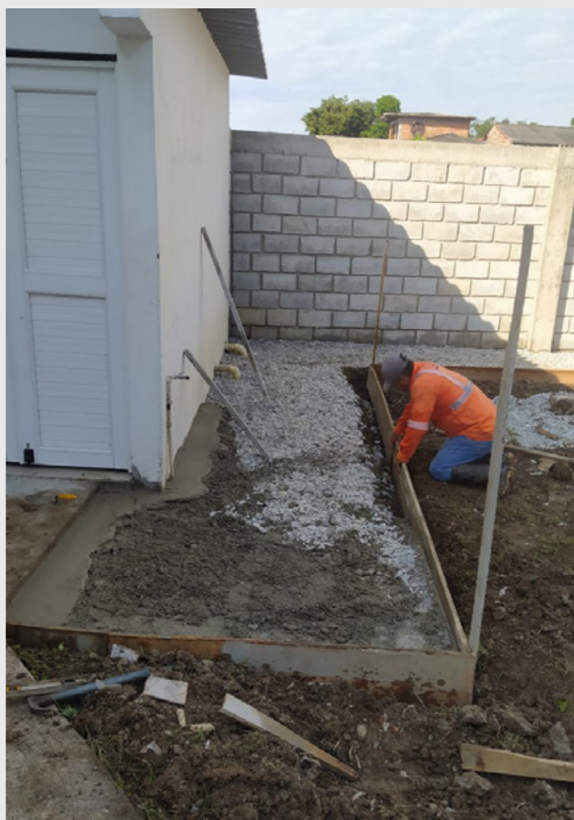
Donación de material de relleno, hospital San Esteban, Puerto Triunfo. Calidra Colombia.
