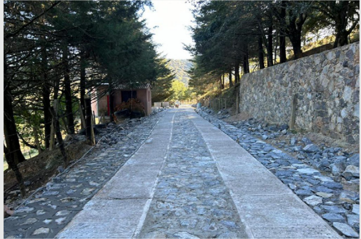
Collaboration in the project "Huellas de camino" (Kilometer 58 Community, Villa de Zaragoza S.L.P.), Cal Química Mexicana (Kilometer 58 Community, Villa de Zaragoza S.L.P.), Cal Química Mexicana
